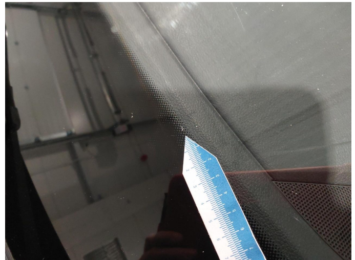
Gebrauchsspur 3: Verglasung: Frontscheibe - Steinschlag - kein Abzug
